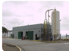
Tanque de separação
