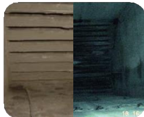
Antes e depois da limpeza
